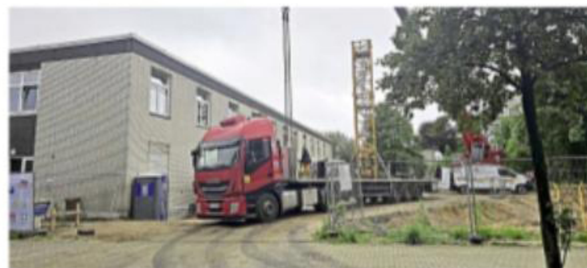
Die alte Post ist gut sichtbar im Umbau.
