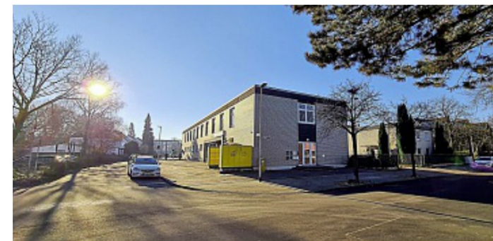
Für die Sanierung und Erweiterung der alten Post wird der Wohnungsverein 1902 als Bauträger fungieren.
